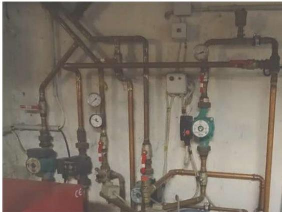
Ungedämmtes Kupferrohr 1,0 W/cm bei Hochtemperatur
